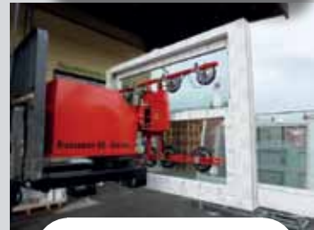
Be- und Entladen von Hebeschiebeelementen
