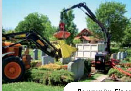
Bagger im Einsatz
